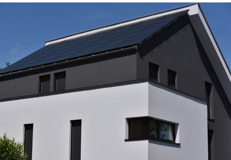
Maison privée / passive © TR Engineering S.A.
