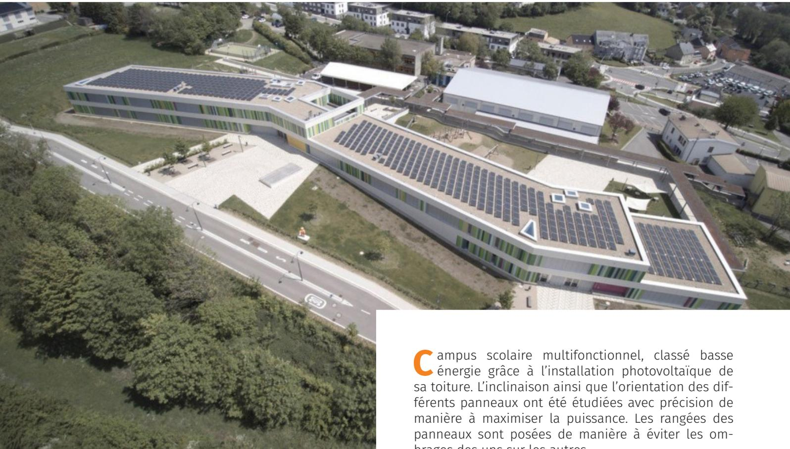
**C**ampus scolaire multifonctionnel, classé basse énergie grâce à l'installation photovoltaïque de sa toiture. L'inclinaison ainsi que l'orientation des différents panneaux ont été étudiées avec précision de manière à maximiser la puissance. Les rangées des panneaux sont posées de manière à éviter les ombres des uns sur les autres.
