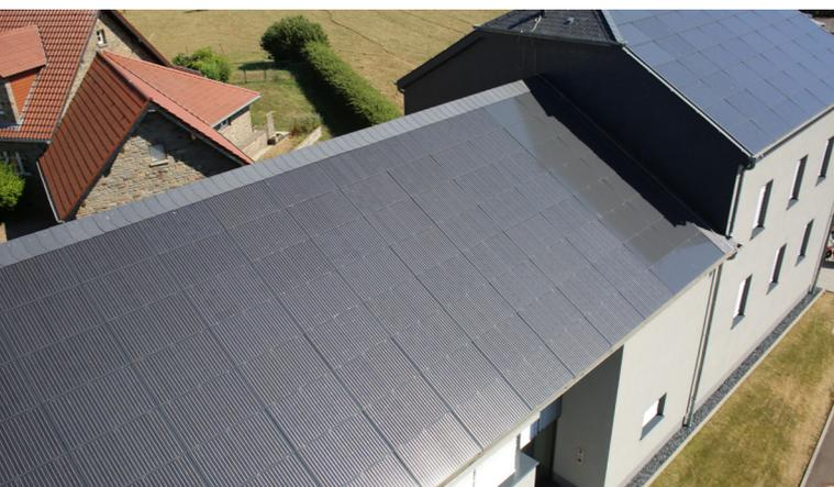
**L**e panneau solaire comme alternative aux tuiles traditionnelles ! Pour créer un système de production d'énergie renouvelable alliant performance et esthétique, 88 panneaux photovoltaïques ont été intégrés à la toiture. Ils ont été sélectionnés pour optimiser les matériaux utilisés dans la conception du bâtiment. Ainsi, ils assurent l'étanchéité de la toiture.
