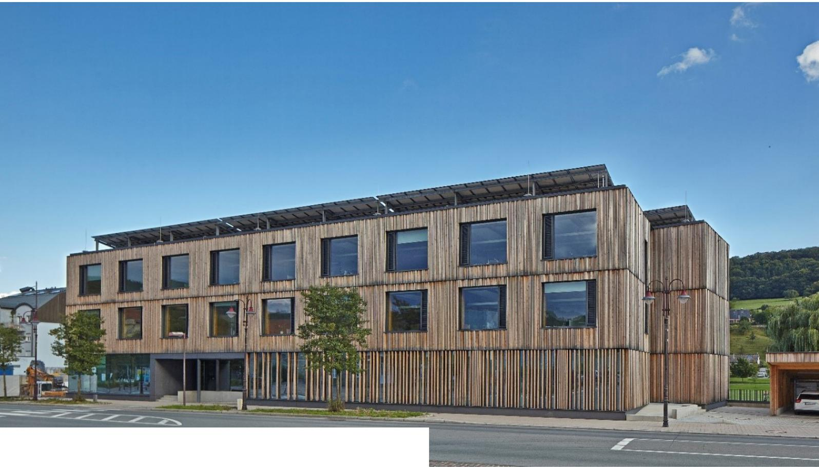
**S** iège de l'Administration de la nature et des forêts et premier bâtiment public luxembourgeois à énergie positive. Construit au bord de la Sûre, des panneaux photovoltaïques ont été installés en toiture, sur la façade sud ainsi que sur l'ensemble du carport.
