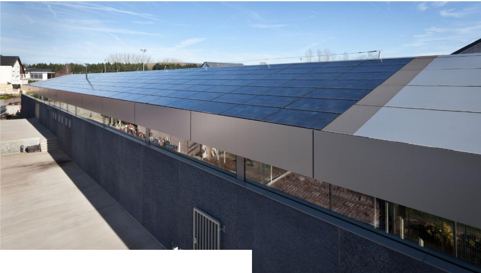
Il s'agit d'un nouvel atelier communal avec deux halls, le premier accueillant le service technique et le deuxième le service d'incendie. Les panneaux solaires ont été intégrés sur le côté sud-ouest de la toiture sur une surface de 260 m<sup>2</sup> pour une puissance de 177 W/m<sup>2</sup>. Cette dernière est de construction métallique avec tôles à profil trapézoïdal et panneaux composites en aluminium. Une bande vitrée sépare la toiture des murs et lui donne un aspect flottant.
